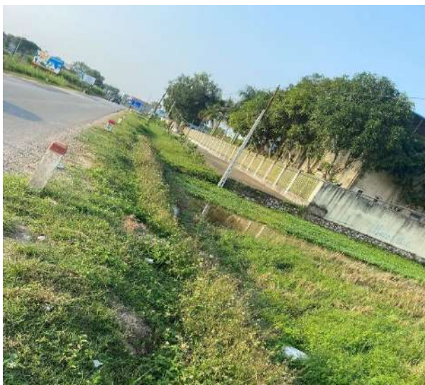
Tuyến mương đào dọc tuyến đường giao thông 47C
